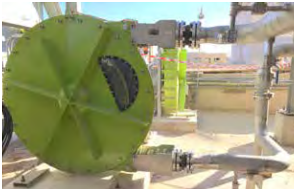
ALH125 pompująca beton
