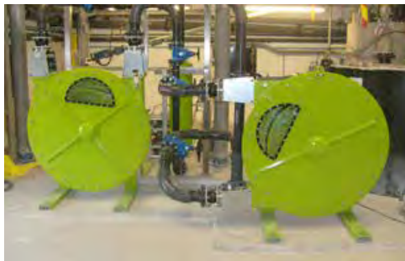
ALH100 do przetłaczania wody wapiennej w oczyszczalni ścieków
