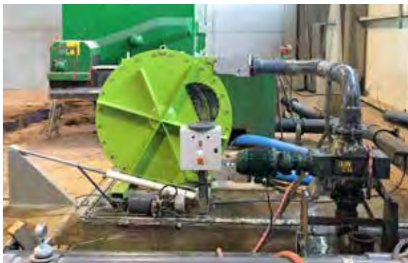
ALH125 w instalacji wytwarzającej biogaz
