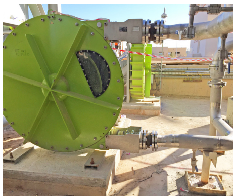
ALH125 para bombeo de hormigón
