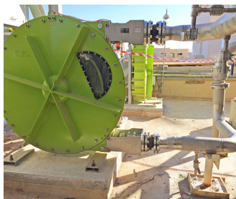
ALH125 bombeamento de concreto
