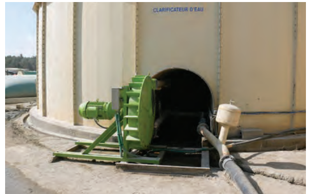
ALH100 beim Pumpen eines Eindickerunterlaufs in einem Steinbruch
