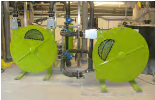
ALH100 用污水处理厂投加石灰水
