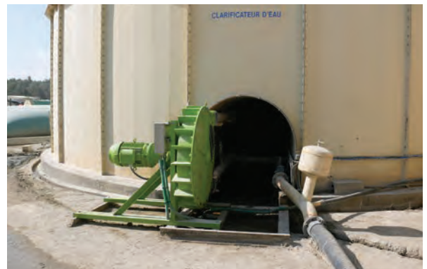
ALH100 bombeando el desbordamiento del espesador en una cantera
